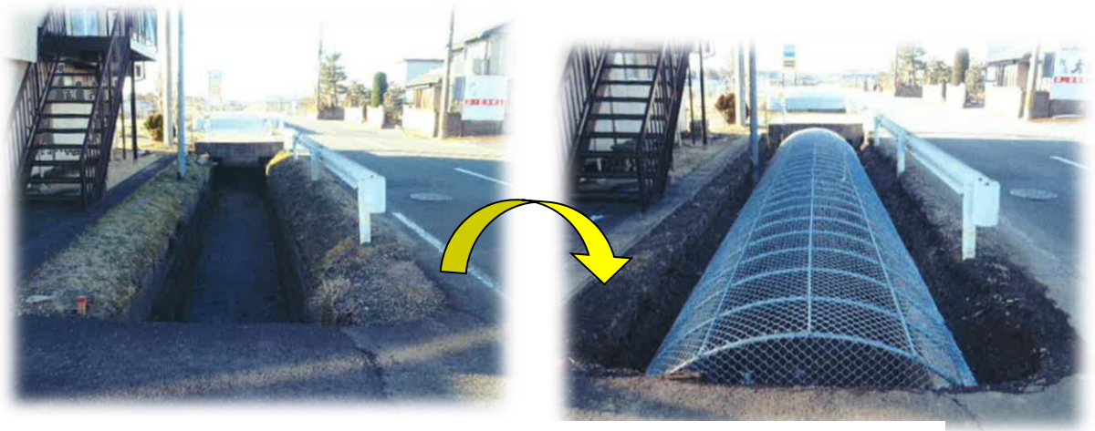
矢吹第3・4合流幹線用水路安全ネットカバー設置工事
