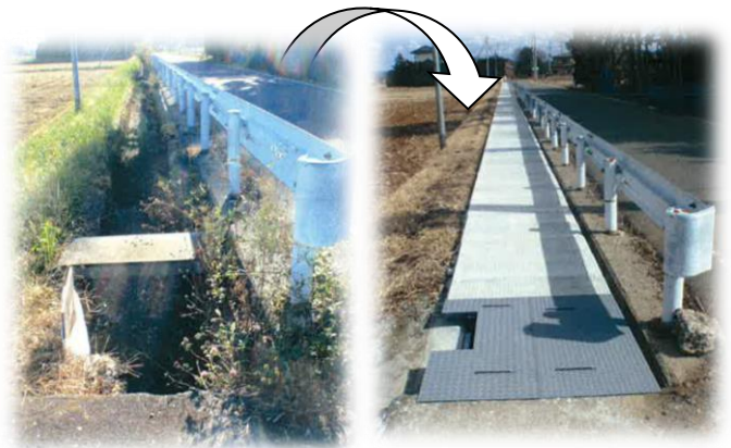
矢吹第4幹線用水路蓋掛工事
