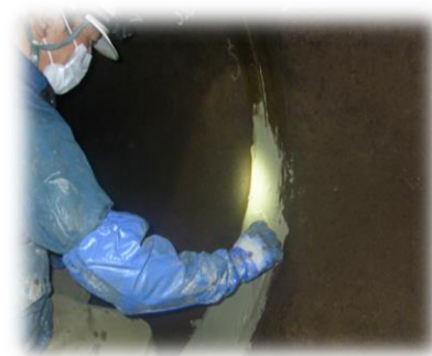
地区内導水幹線用水路 管内コーキング
