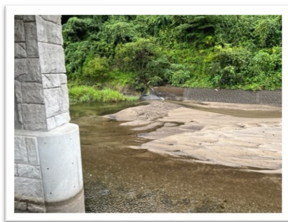
ゴム堰の上に土砂が堆積している様子
