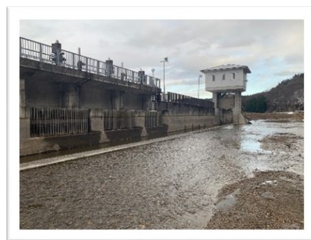
日和田頭首工土砂撤去後
